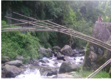
निर्माण अघिको अवस्था
